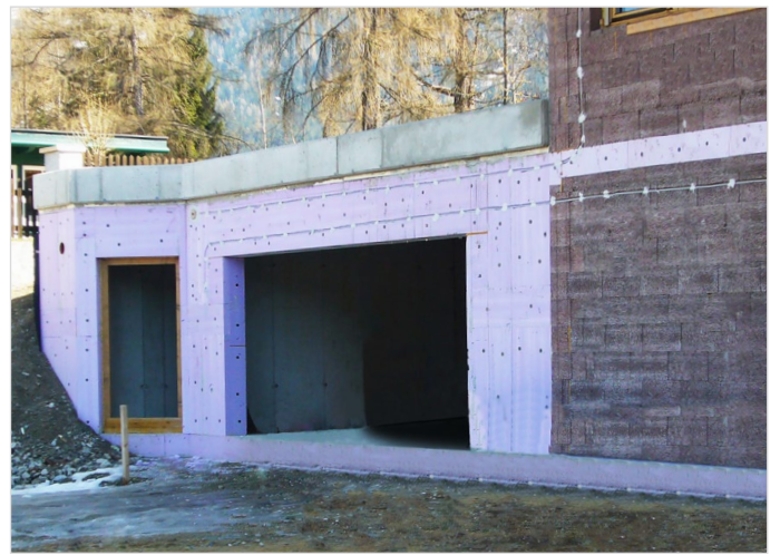
Thermal bridge insulation with JACKODUR® Gefiniert
